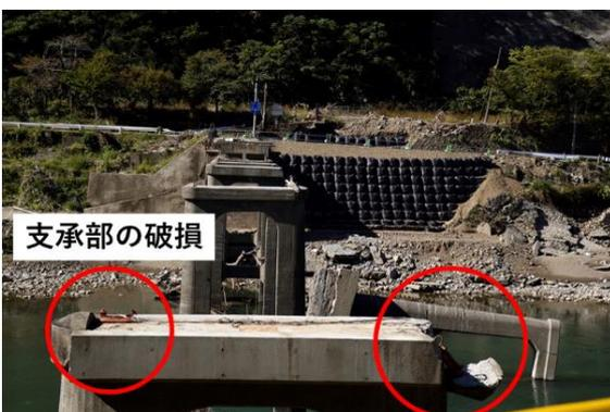
(c) 支承の破損・脱落
