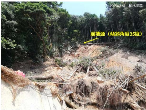
写真 2.2 破壊された擁壁からの崩壊斜面
