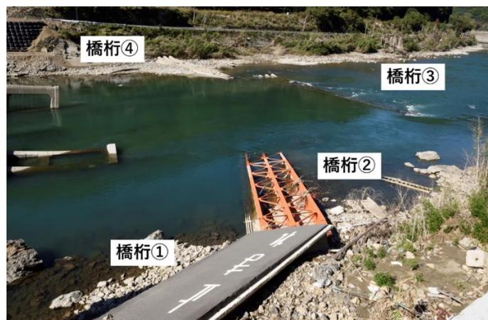
(d) RC 桁の流失
