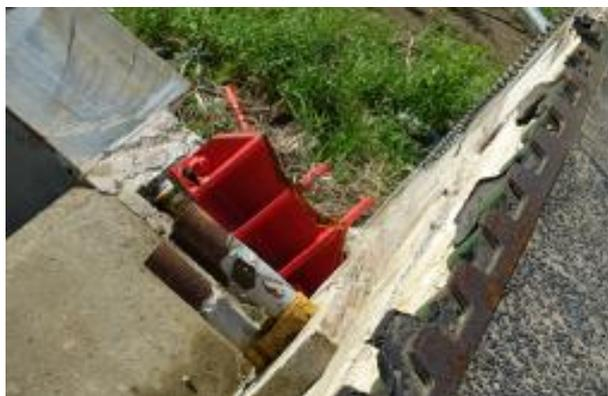
(d) 右岸下流側の固定支承の破損
