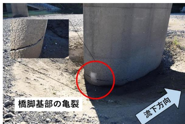
(c) 橋脚基部の亀裂
