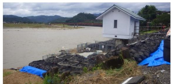
写真 5.2 球磨川堤防決壊の様子(56.4k右岸)
