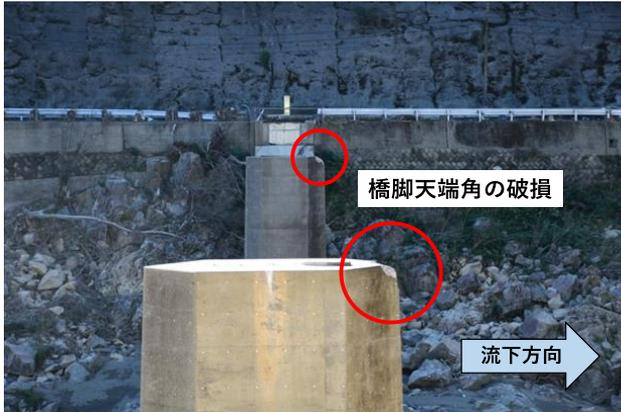
(a) 橋脚および天端の破損
