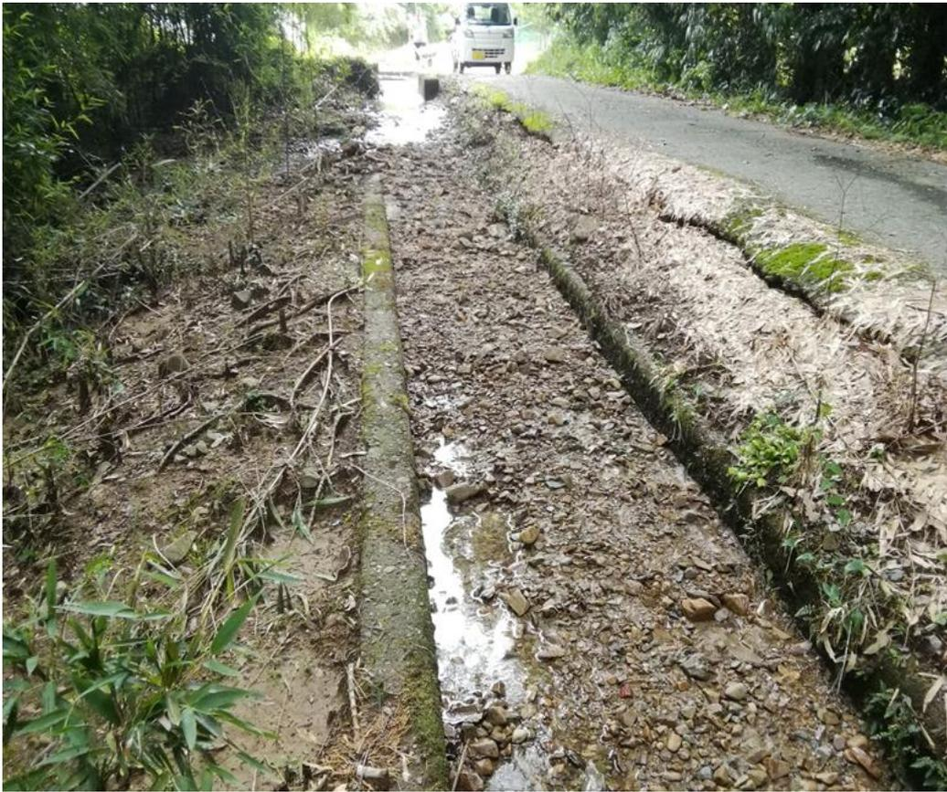
図 3.2 幸野溝用水路に堆積した土砂（熊本県農林水産部提供）
