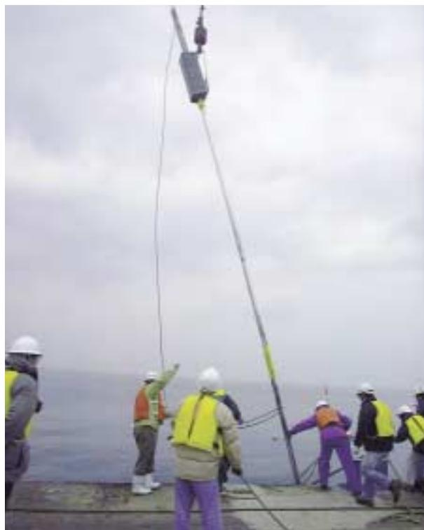
熊本新港沖で実施したコアリング作業(海底に長さ15mのアルミ製パイプを突き刺して、乱れのない堆積物を採集する)
