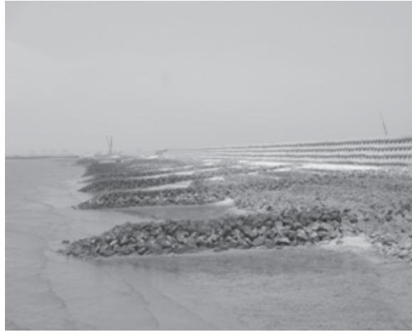
写真-7 既設の防護海岸に連続突堤と盛砂の施工による新たな海岸堤防の建設：消失した生物生息場が回復するとともに景観・親水機能も向上（熊本県玉名横島海岸）
