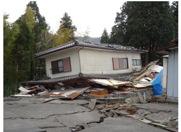
南阿蘇村の木造家屋の崩壊 1階が完全に潰れている
