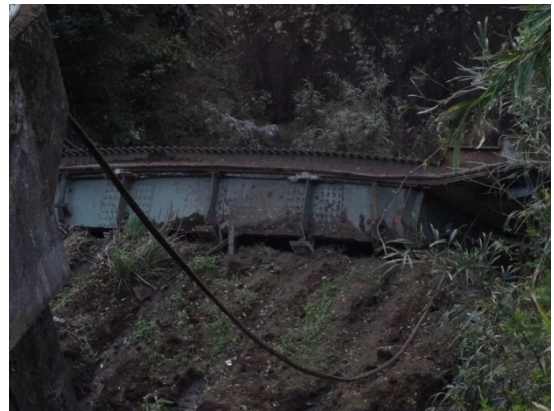
滝室側の斜面崩壊により阿蘇大橋が落橋
