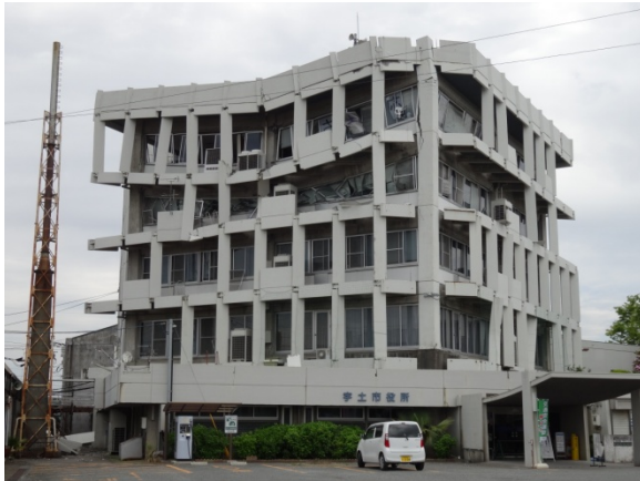
5階建ての4層目が層崩壊寸前 兵庫県南部地震でも類似の被災例多 数建て替えが計画されていた
