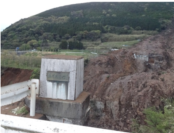
滝室側の斜面崩壊により阿蘇大橋が落橋
