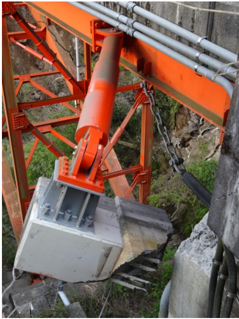
南阿蘇橋ダンパーの取り付け部の損傷
