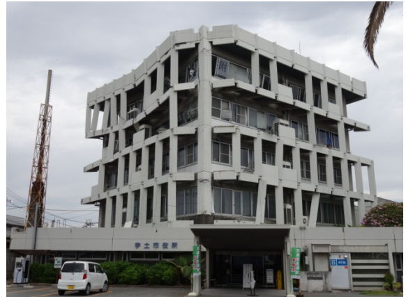
宇土市役所庁舎の被害
