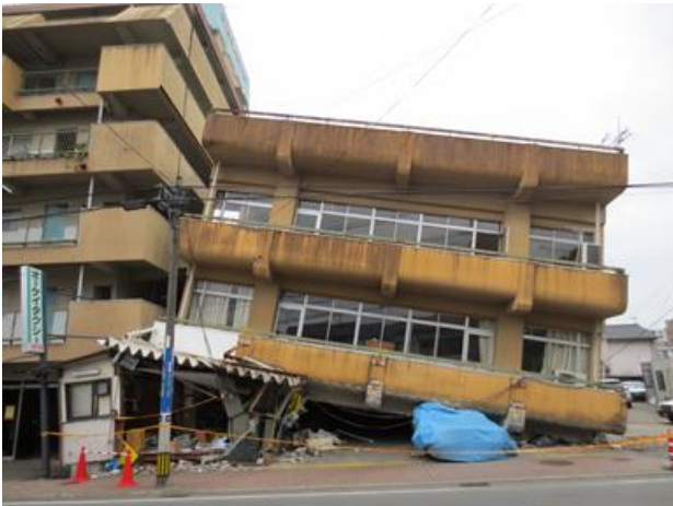
ピロティの柱が座屈し、傾いている熊本市内の建物。
