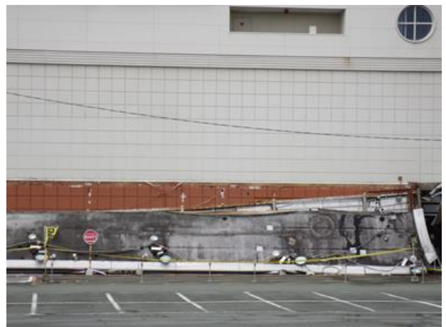
大型店舗の一階部分の屋根がすべて崩落している。
