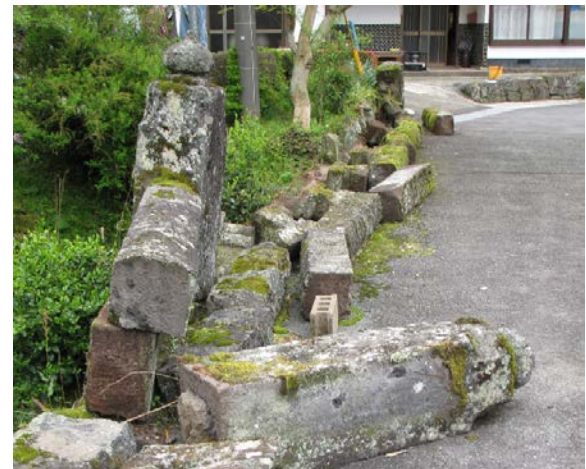
写真4 永山橋の高欄崩壊
