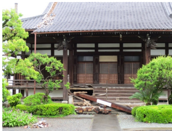
天井の構造物が落下し、床や階段を壊していた。
