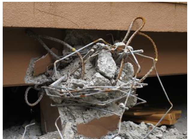
柱が完全に潰れていました。
