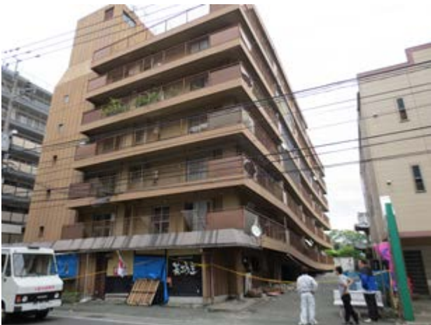
1階のピロティの駐車場が完全に潰れている熊本市内のマンション1
