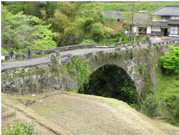
写真3 永山橋の高欄崩壊と落下
