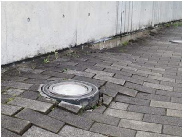
宇城市の避難所の1つウイングまつばせの建物の周りも地盤沈下していた。
