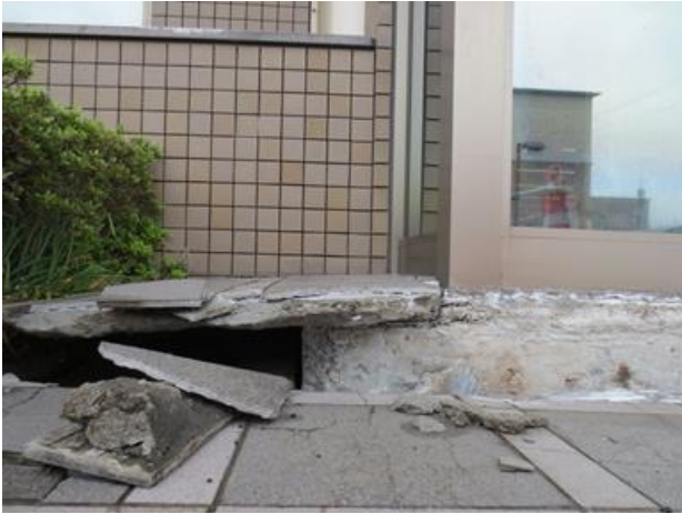
宇城市災害対策本部が設置されている宇城市役所の周囲は地盤沈下，基礎杭は大丈夫で庁舎に傾きは見られない。
