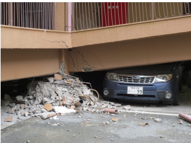
1階のピロティの駐車場が完全に潰れている熊本市内のマンション2
