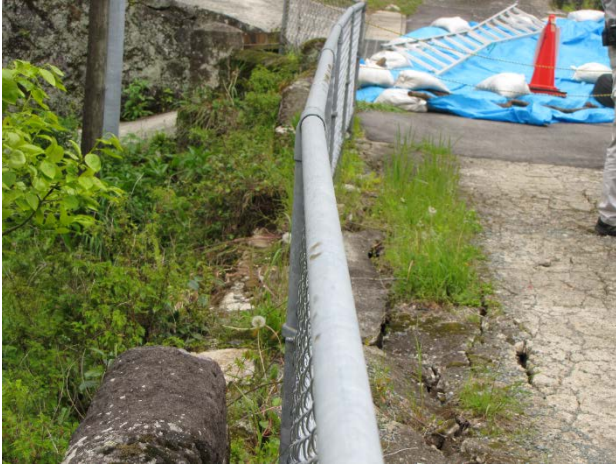
写真1 立門橋上流側の壁石の脹らみ
