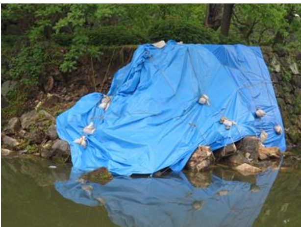
熊本城だけでなく県南の八代城跡の石垣も崩落。
