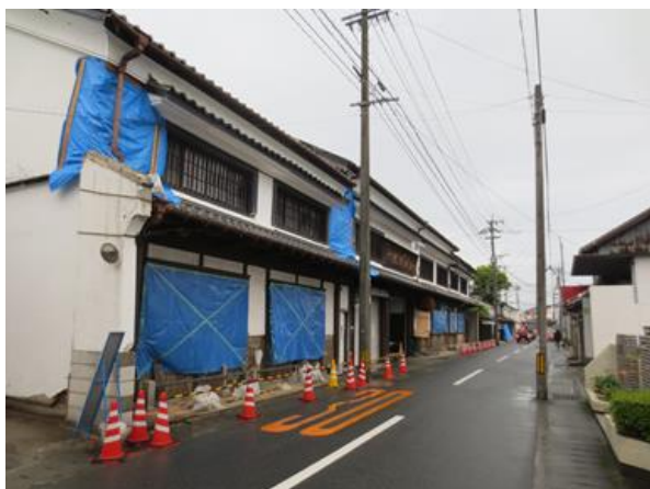
古い建築物が残る川尻の通りも壁がはがれ落ちたり、瓦が落下したりしている。
