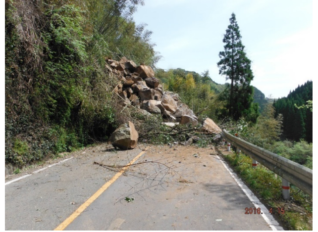
国道 445 号を塞いだ溶結凝灰岩の岩塊 幅約 20m、高さ約 10m
