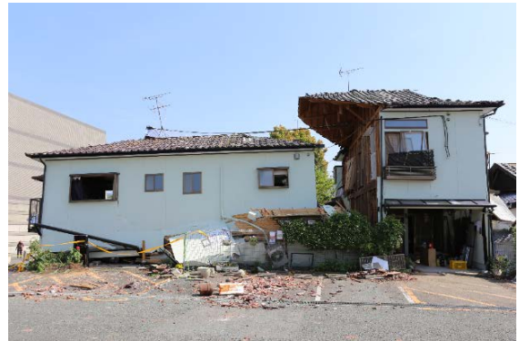
1階が崩壊し、真二つに分かれた建物
