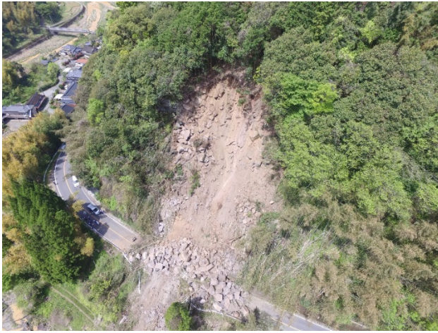
国道 445 号上益城郡御船町下鶴の斜面崩壊 写真提供：国土交通省熊本河川国道事務所
