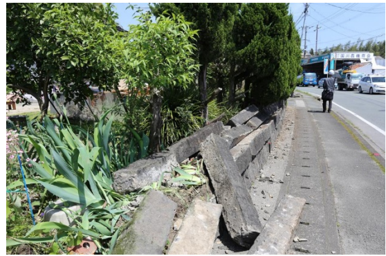
石積みの塀も崩落していた。
