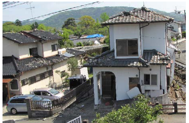
屋根を中心に建物全体が被害
