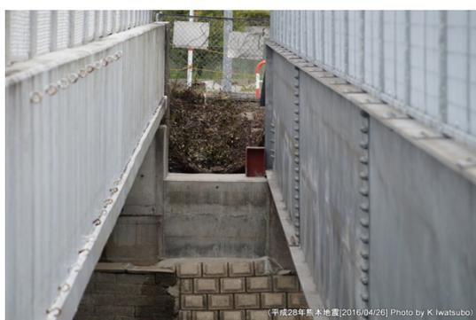
車道部は段差の補修後に通行可能となっているが、歩道橋は支承から外れて落下している。設置箇所の影響か、構造的な要因なのか原因は不明である。
