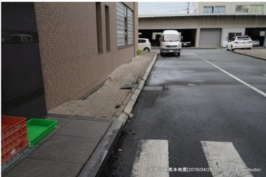
災害対策本部が置かれている宇城市役所。駐車場や入り口付近には地割れの跡が見受けられた。2枚目の写真は、新館横のインターロッキングの部分には波打ったようになっていた。下部に何らかの管が入っているような部分に併せて波打っていた。自衛隊の支援隊の拠点となっていた。
