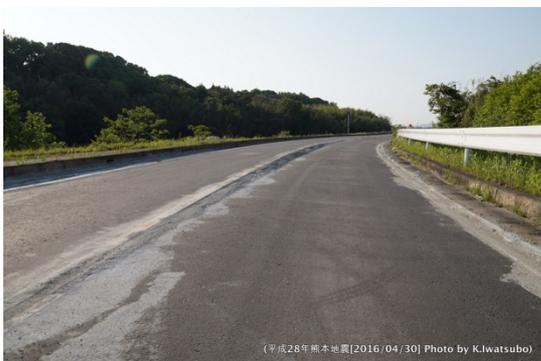
御船川横の堤防の斜面が崩壊し、先に向かって幅員中央に段差が生じていた。
