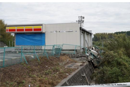
県道266号線から県道 313 号線に入る高速道路上の跨道橋で、周囲に斜面崩壊や噴砂の跡が確認出来た
