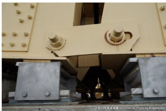
2連のトラス橋を連結し、それぞれに落橋防止装置もついていた。この橋台部分が沈下したため、上弦材に圧縮が作用し圧壊と座屈が発生していた。橋上に昇る階段もはずれていた。また、上流に架かる新鏡川橋は、25日には通行可能であったが、28日は通行止めとなっていた。荷重制限のためと考えられる。
