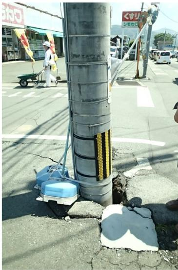
益城町県道 235 号線沿い 益城郵便局近くの電柱. 沈下が見られる.
