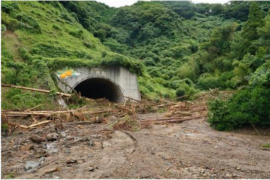
田浦トンネルを塞ぐ土石流堆積物
