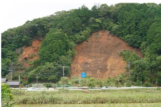
モルタル、法枠工による斜面が崩落
