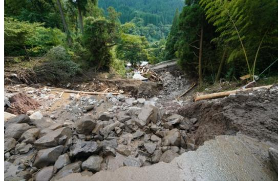
図16 図15の下方へ土石流は道路を破壊し流下する。
