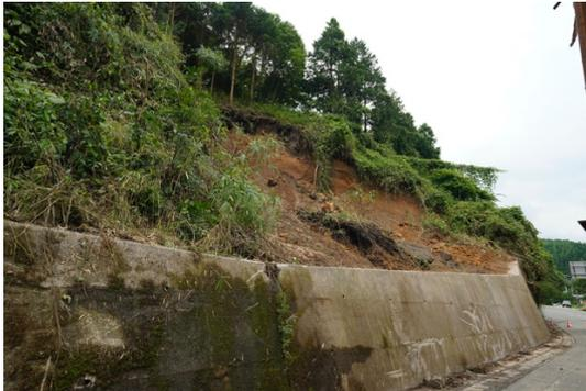
図17 小国町宮原国道212号での斜面崩壊。Aso-4火砕流堆積物の風化部とテフラ層が崩落する。
