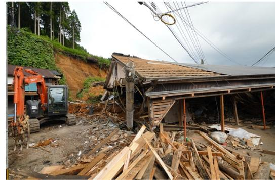
図18 小国町宮原での崩壊。崩壊土砂により県道178号上に家屋が押し出されている。
