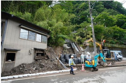
図 5 家屋の中に崩壊堆積物が流入する。礫は杖立層と思われる凝灰質シルト，溶結した Aso-4 火砕流堆積物，溶岩からなる。
