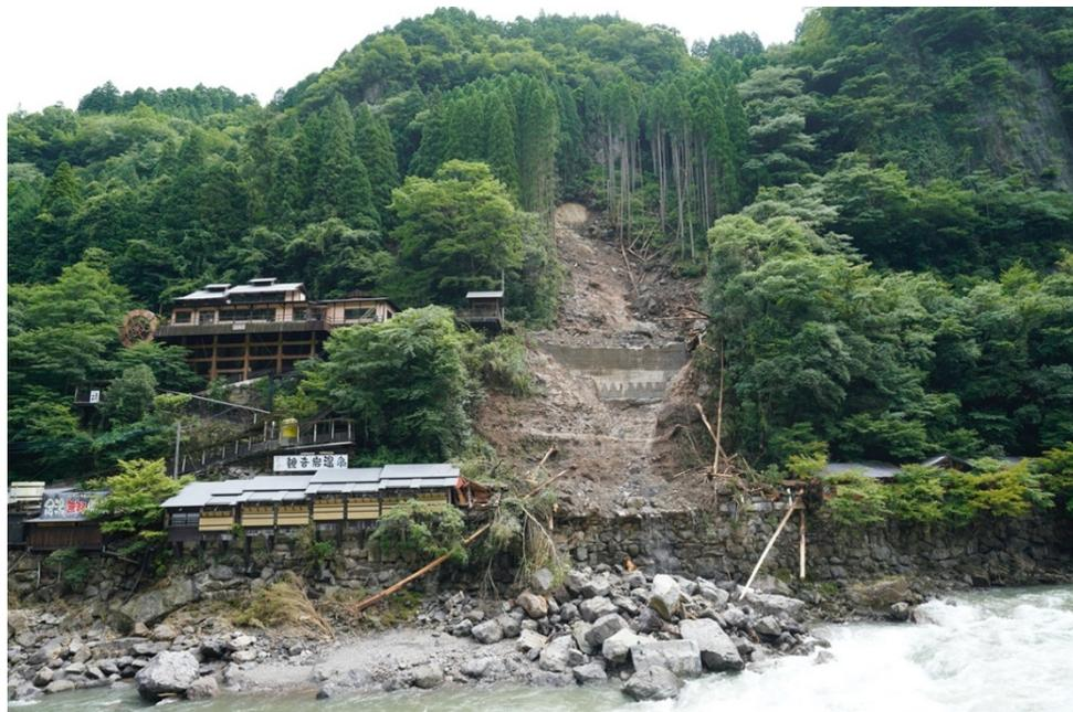
図1 小国町下城の杖立川右岸での崩壊。斜面上部は Aso-4 火砕流堆積物の柱状節理，斜面下部は凝灰角礫岩からなる。崩壊は Aso-4 火砕流堆積物最下部の非溶結部からのものである。崩壊堆積物の多くは斜面谷部に堆積していた崖錐堆積物と思われる。
