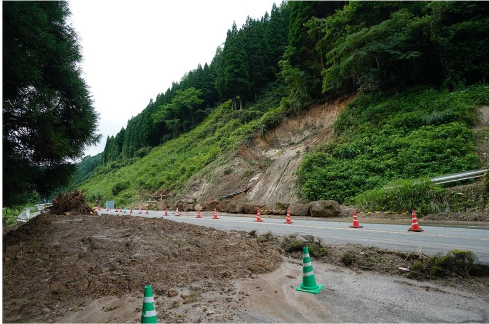
図 3 小国町下城国道 212 号付近での崩壊. Aso-4 火砕流堆積物の非溶結部～弱溶結部が崩壊している.
