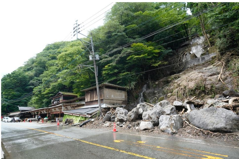
図2 小国町下城国道 212 号付近での崩壊。斜面上部は Aso-4 火砕流堆積物の柱状節理，斜面下部は溶岩からなる。崩壊頂部は確認できていないが，流下した巨礫は Aso-4 火砕流堆積物の強溶結である。
