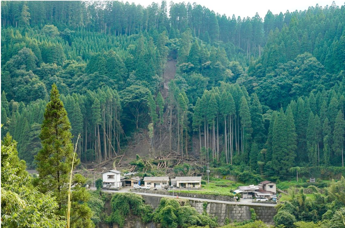
図 12 小国町向鶴での崩壊. 斜面上部は非溶結の Aso-4 火砕流堆積物, 中部は柱状節理を呈し強溶結, 下部は溶結した火砕流堆積物. 崩壊は上部の非溶結部で発生している.
