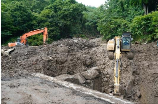
図15 小国町黒淵で道路によってダムアップした土石流堆積物
