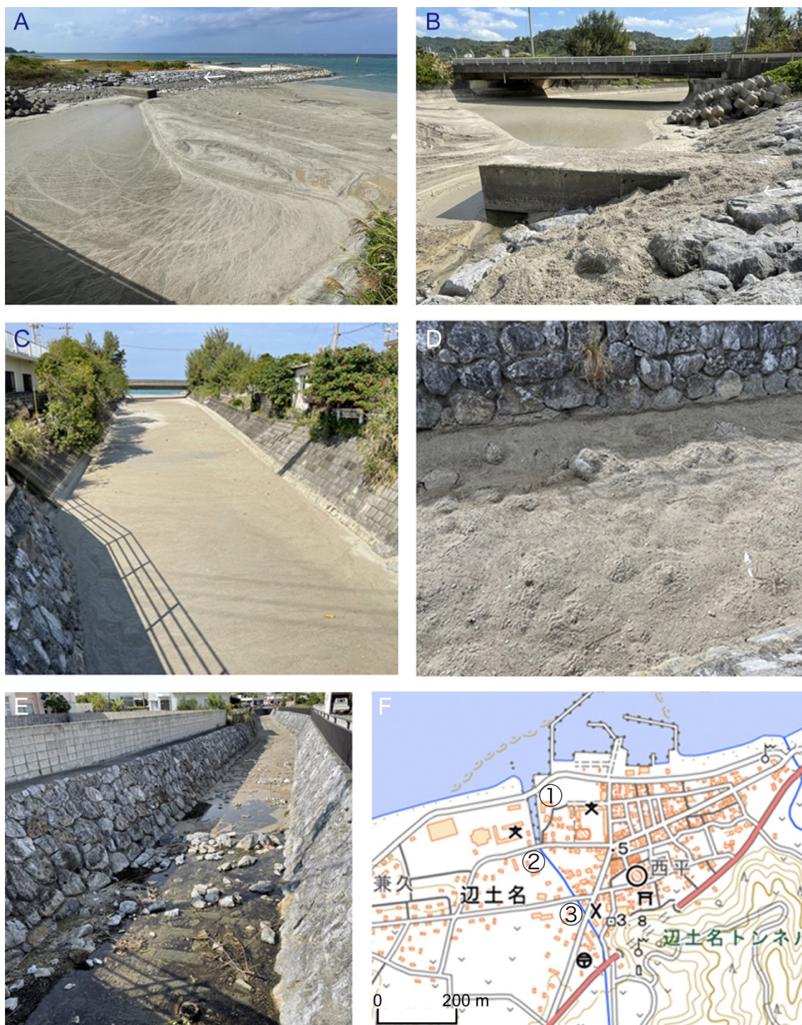
図 6 国頭村辺土名川を遡上する軽石質堆積物。2021 年 11 月 4 日撮影。A) ①の橋から撮影した河口付近。B) 河口付近から①の橋を望む。矢印は高潮位時の軽石の堆積範囲を示す。C) ②の橋から①の橋を遠望する。D) 軽石質堆積物の表面に生じるマウンド群。E) ③の橋付近から下流を望む軽石質堆積物の先端部。F) 辺土名周辺の地形図。「地理院地図」を使用。
