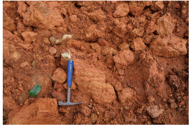
図 16 崩壊堆積物は赤井火山の火砕丘を構成する降下火砕物の風化物。風化により粘土化している。
