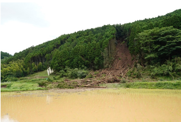
図 11 布田川断層の断層崖での斜面崩壊. 写真左に古い崩壊箇所対策工が見える.
