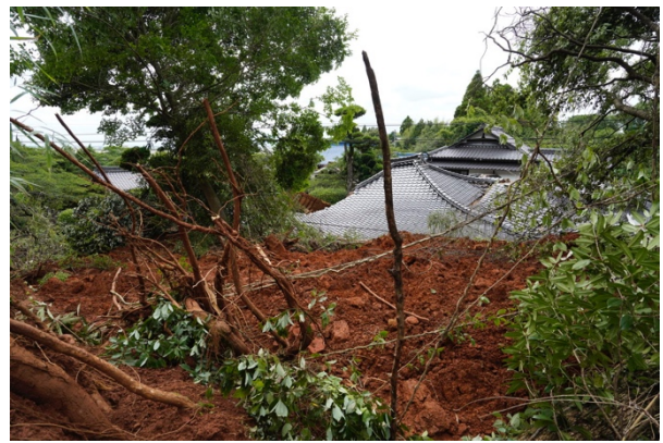
図 14 崩壊面側からみた浄恩寺
