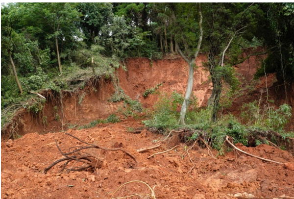
図 15 崩壊面の状況
