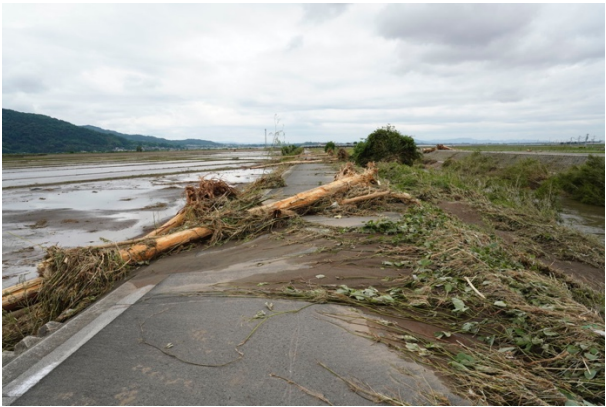
図6 堤防道路に流木が散在する. 写真右が木山川.
