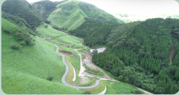
西平川1砂防堰堤全景 (令和6年7月)
