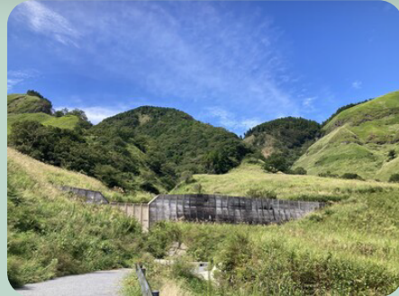
西平川1上流の治山施設 (令和6年8月)
