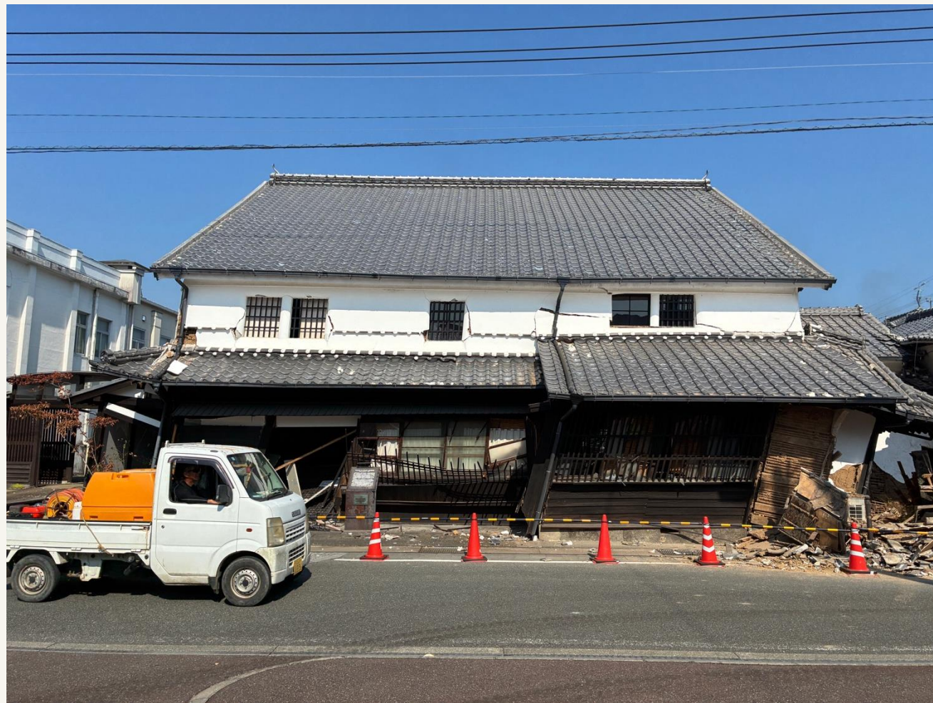
旧井芹家住宅 (氷川町宮原地区)
