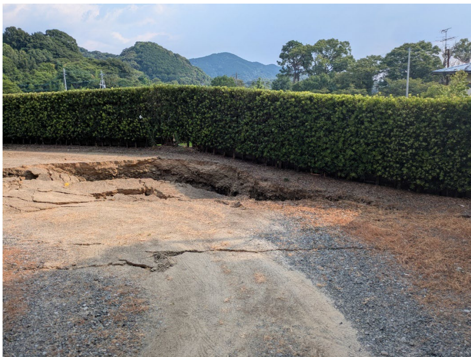
八代 JCT 付近の民家に生じた地表地震断層
