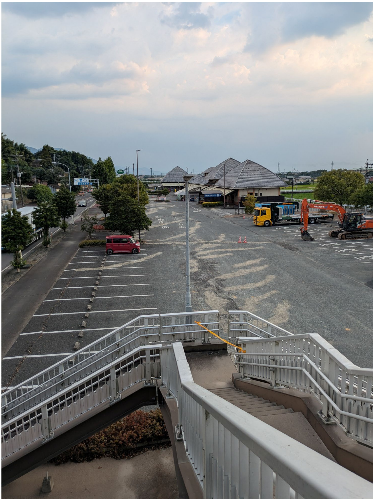
道の駅竜北に生じた地表地震断層
