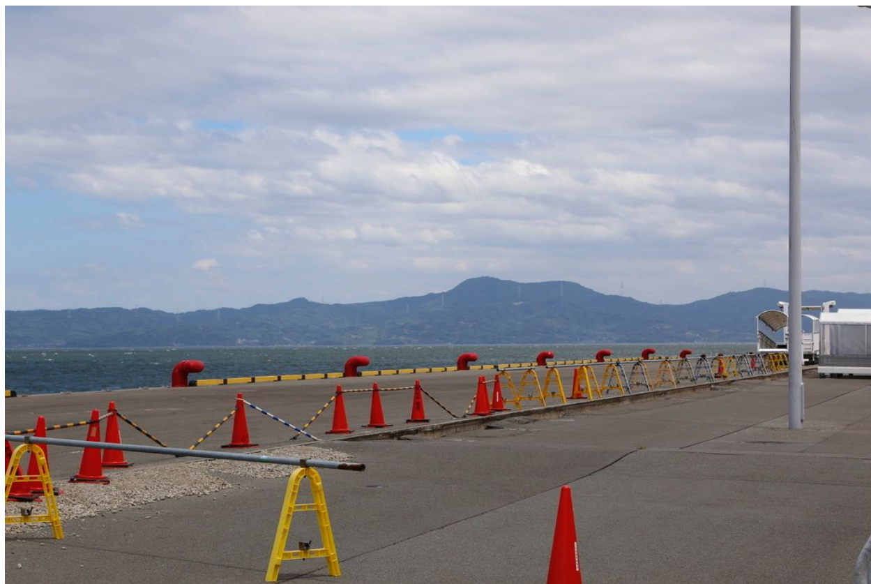
写真7. 旅客ターミナルの地盤に隆起・沈下が発生した.
