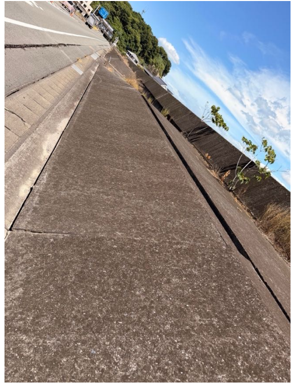
写真 1 8. 道路と堤防に隆起・沈下が発生した。
