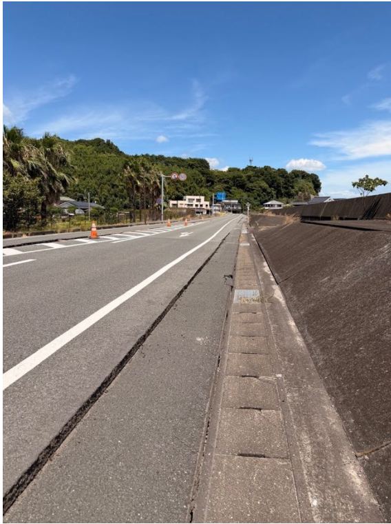
写真 1 8. 道路と堤防に隆起・沈下が発生した。
