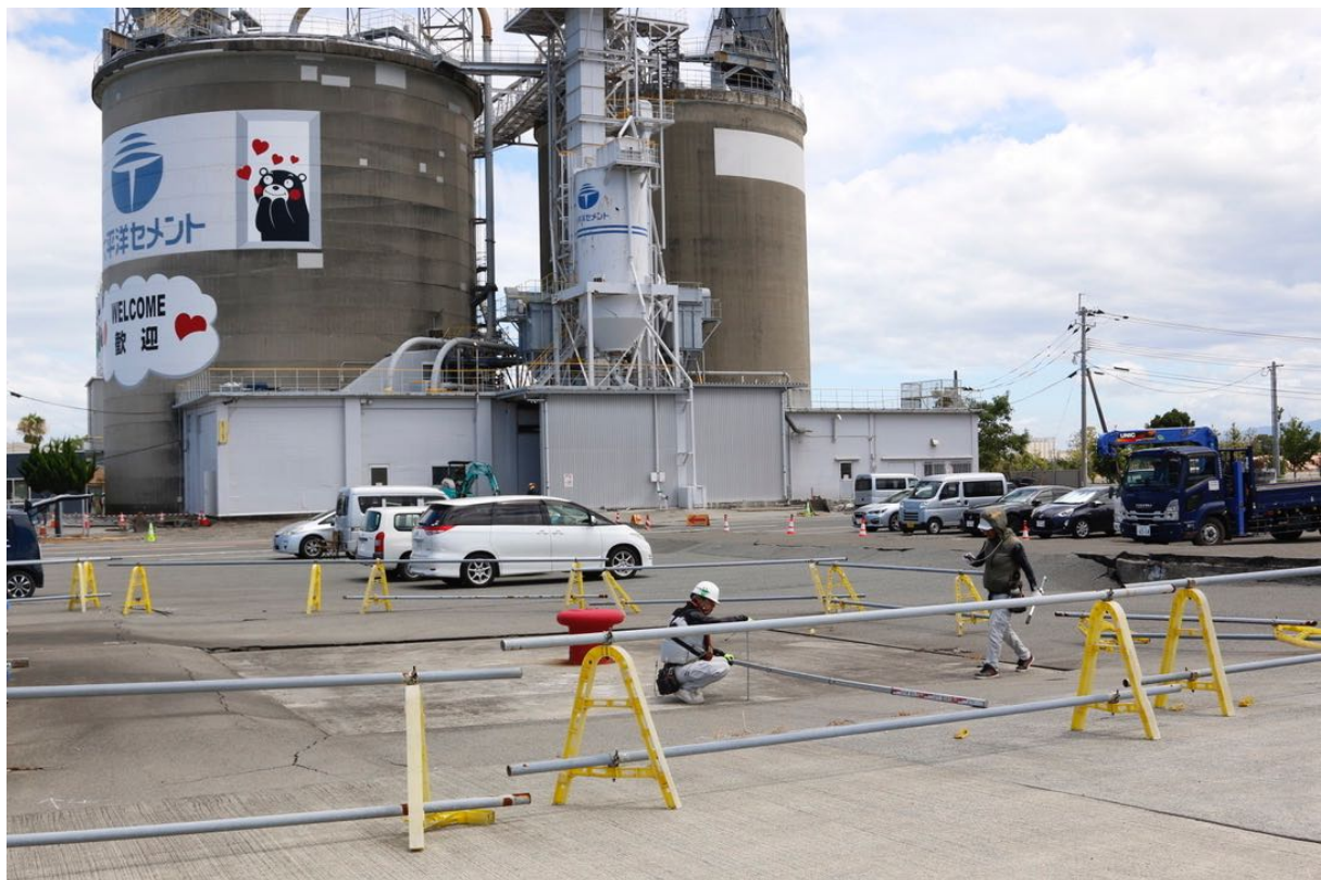
写真5. 港の地盤に沈下が発生した.
