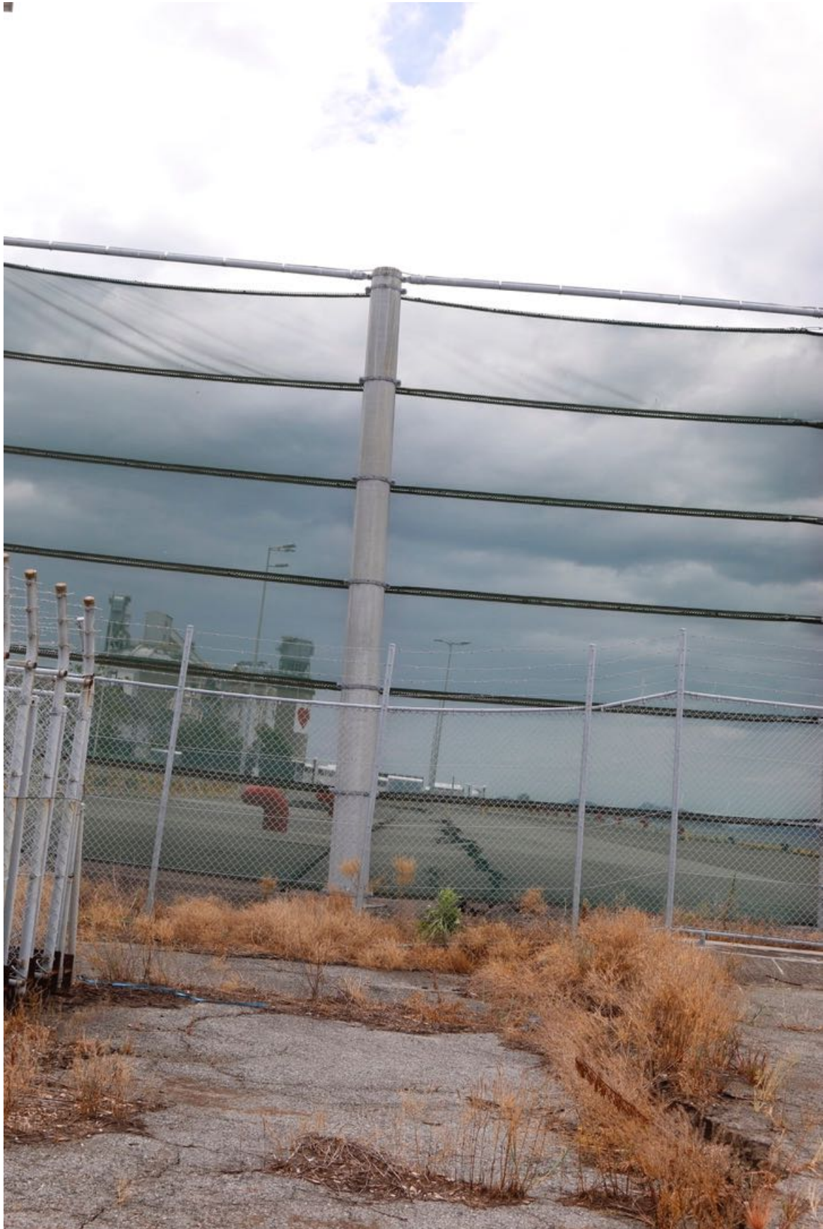
写真 1 3. 旅客ターミナルに隆起・沈下が発生した.
