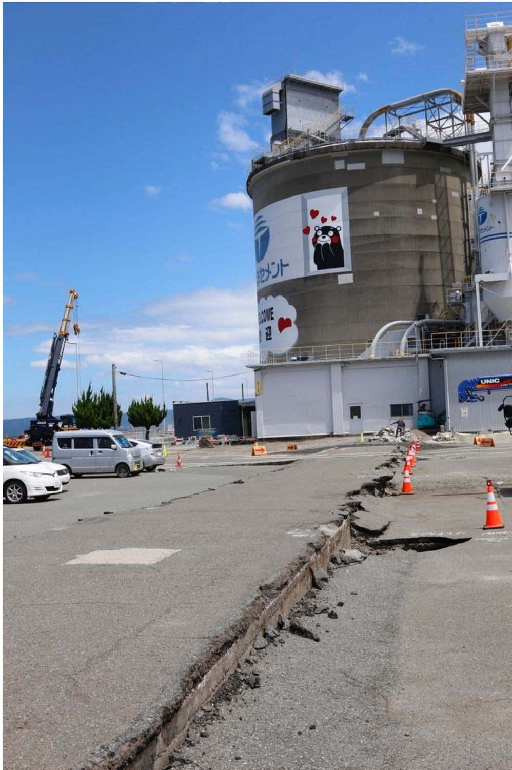
写真6. 港の地盤に隆起・沈下が発生した.
