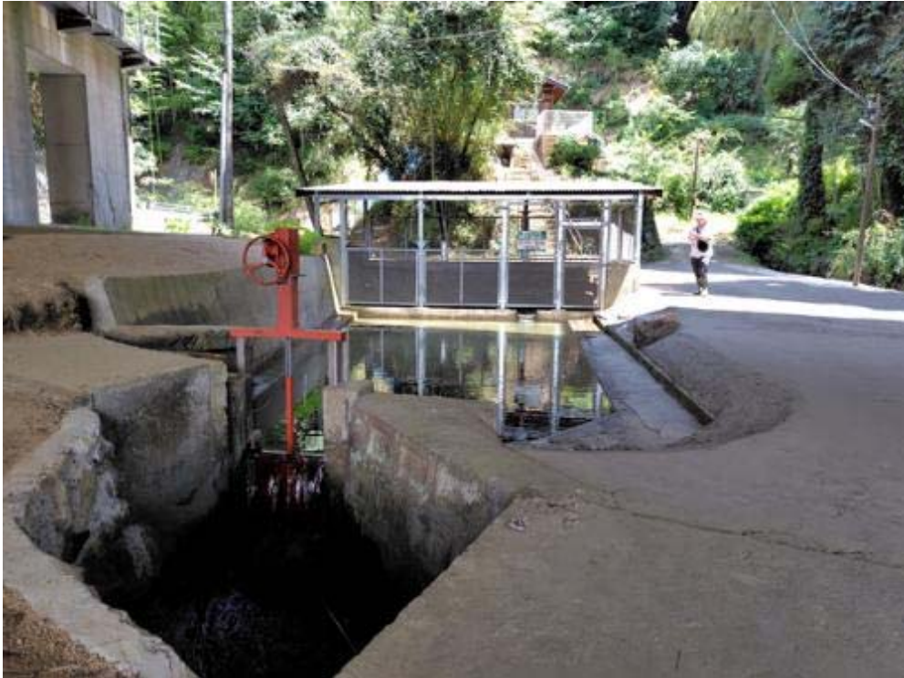
御手洗水源．湧水あり．御手洗水源は地域の生活用水や灌漑用水として利用されている．
