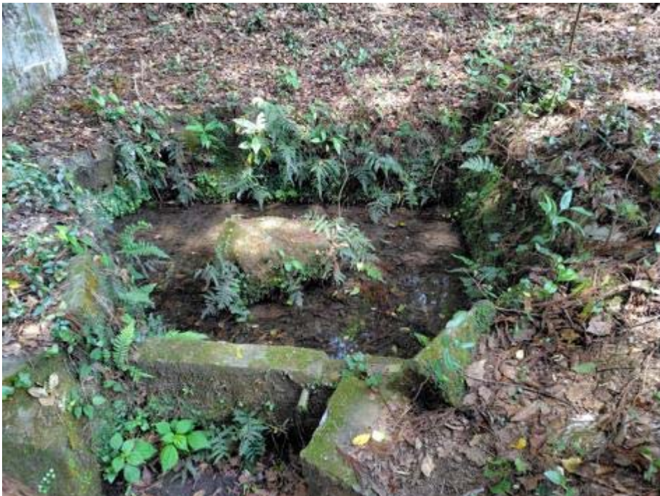
宇城市松橋町小保山の天満宮．鳥居が損壊，湧水はあり．
