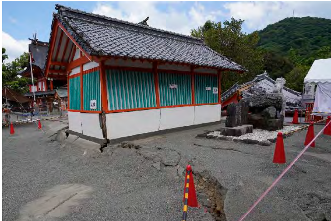
①断層直上の社殿はたわむように変形する
