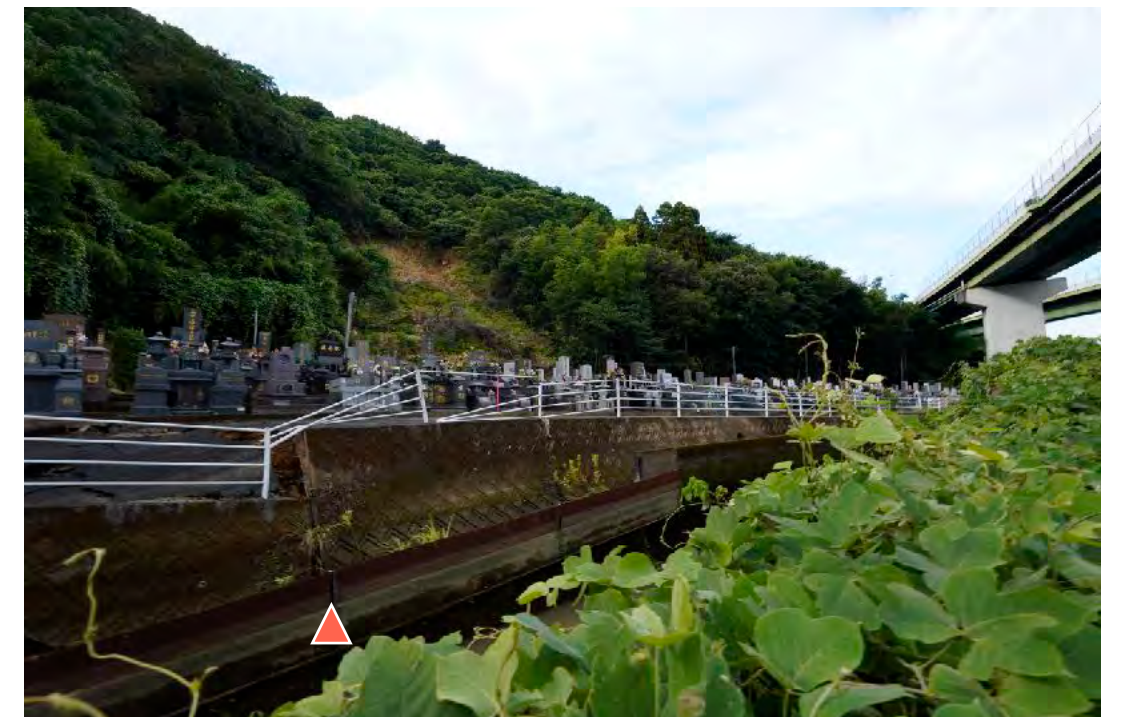
④下り線に影響を与えた断層は墓地も変位させているが、その一方で、墓石の転倒は断層により傾いた部分のみで極めて少ない。△は断層位置
