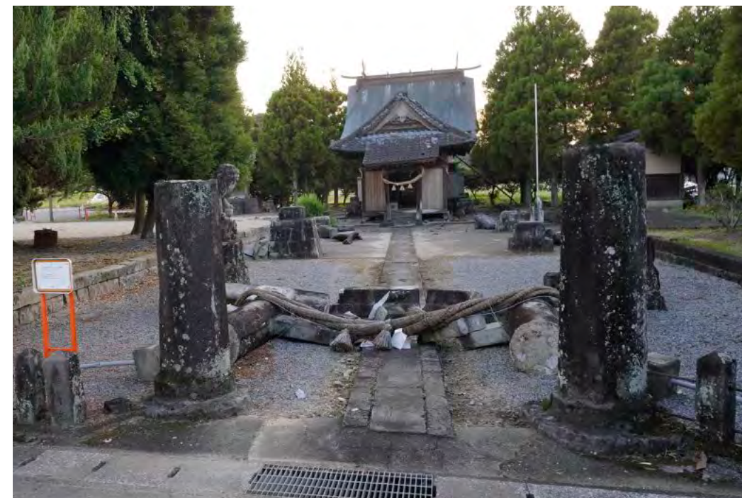
④御船町小坂の二宮神社では鳥居や灯籠が倒壊するが、周辺の住宅での倒壊被害は見当たらない
