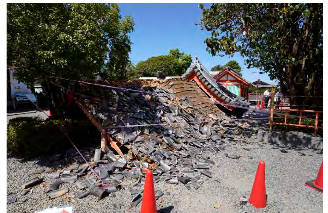
④断層から離れており、地震動により倒壊したとみられる社殿
