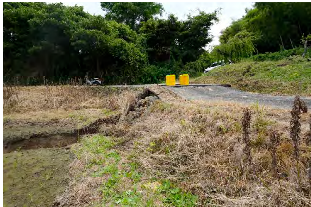
③右横ずれ35cm,南隆起45cmの断層による変位
