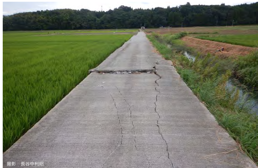
③嘉島町北甘木の東側台地に向かう南北方向の農道に見られる東西方向の圧縮による破壊
