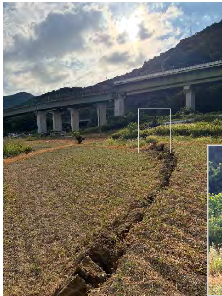
①断層変位は高速道路の橋梁に大きなダメージを与えたが、断層横の墓石には転倒などの損傷は見られない。
