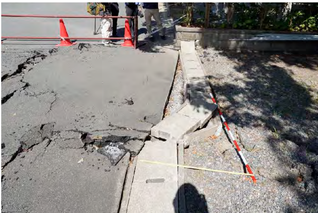
③②の▽位置での側溝の横ずれ
