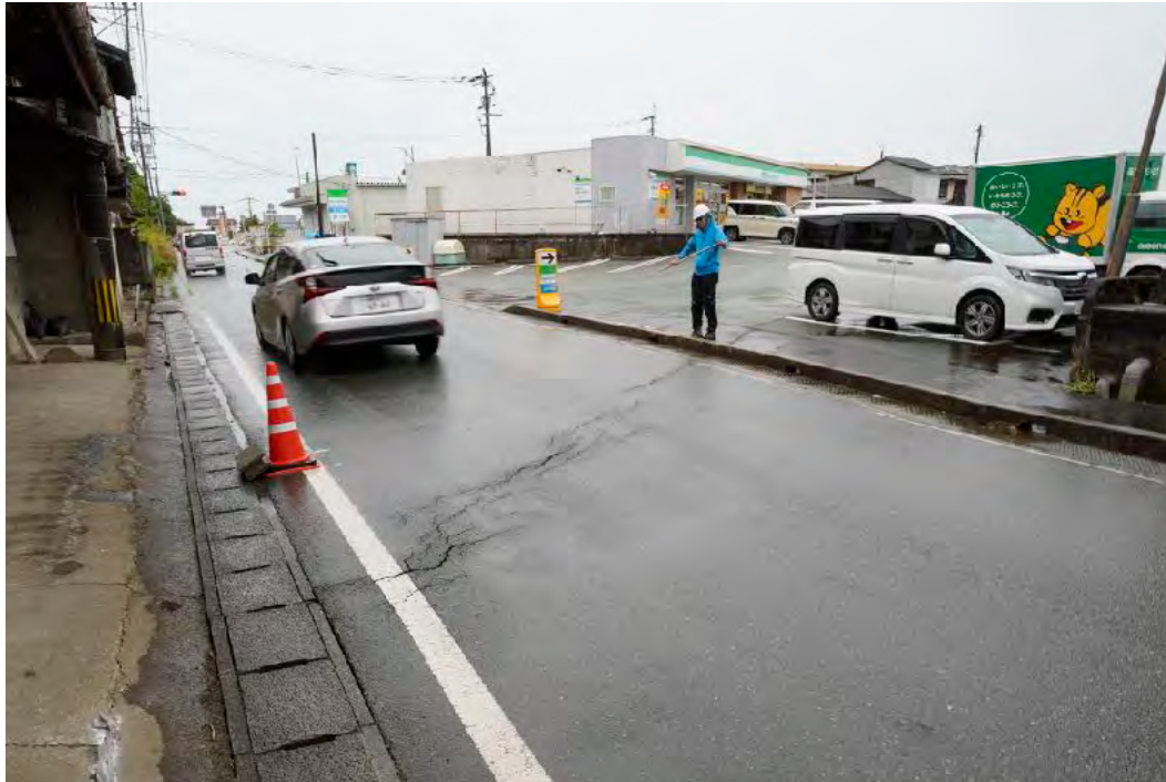
①肥後高田駅近くの道路を横切る断層。変位量は少ないが杉型に雁行する
