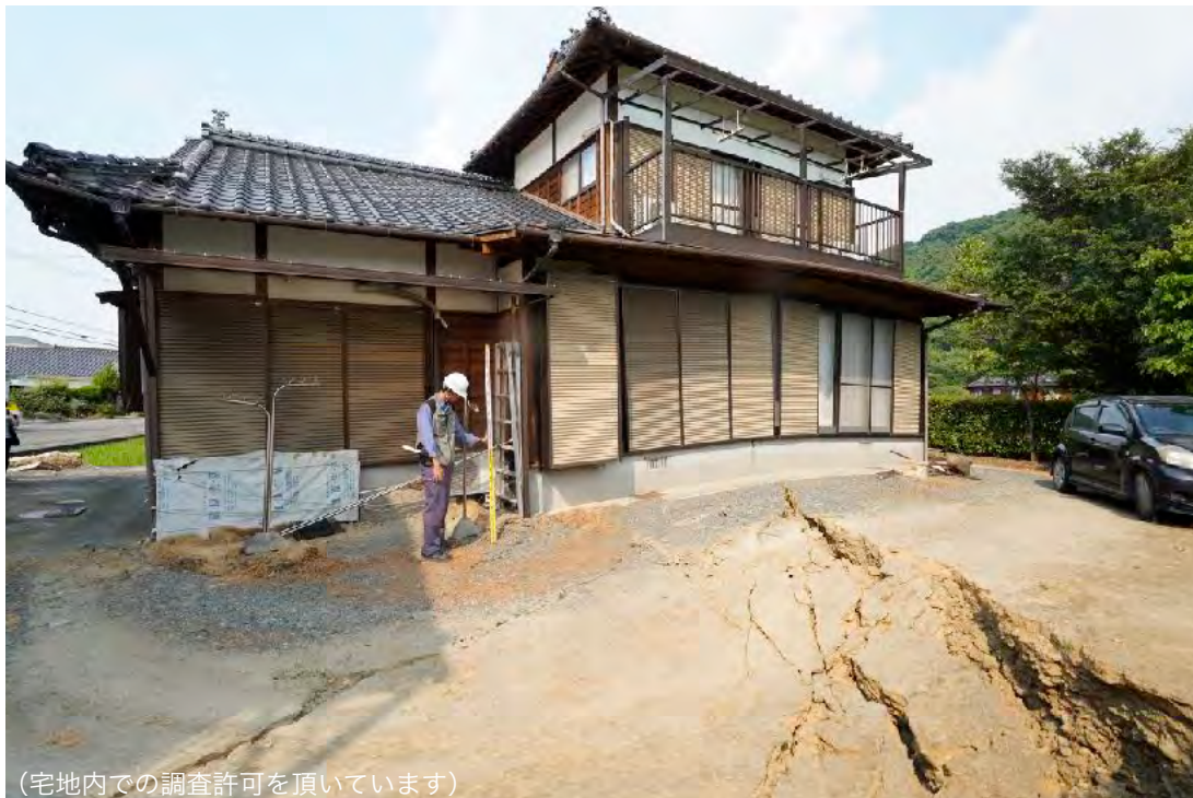
③建物の直下を通る断層により建物が湾曲する。手前の断層崖には砂礫層が認められる。
