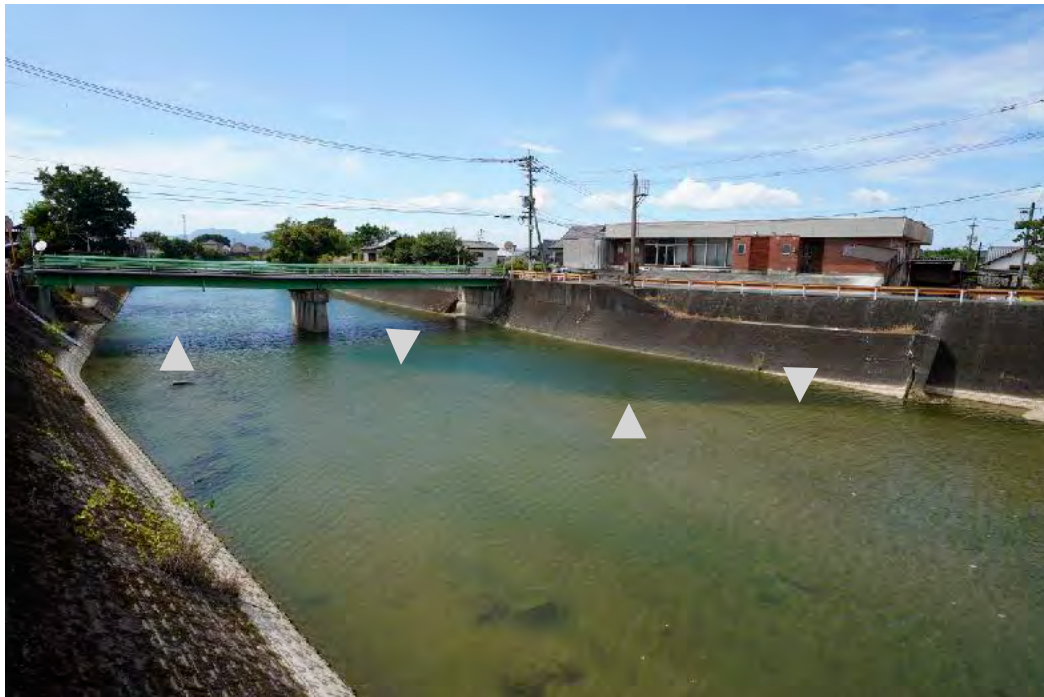
③ 砂川にかかる苧萱橋。②同様に護岸の状況から、川面の色が深くなる境界が断層と推定され、断層は左岸側（写真左）の橋台と橋脚の間を通る
