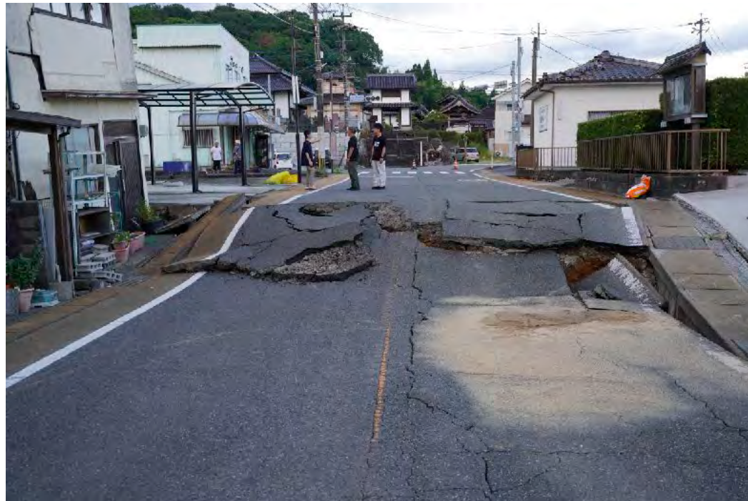
①県道32号線に現われた断層
