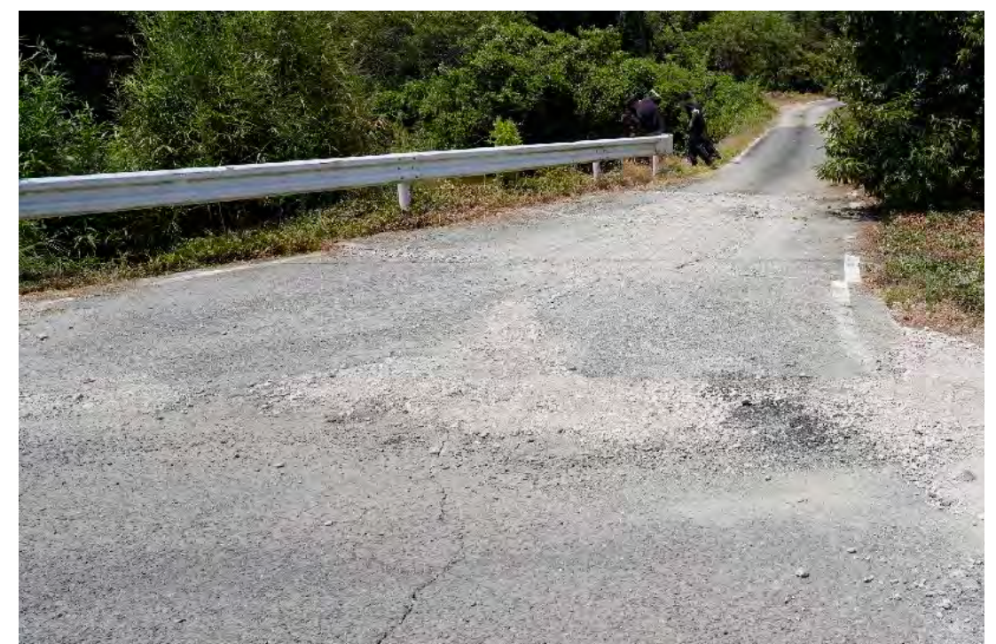
③複数の断層により変位が分散する
