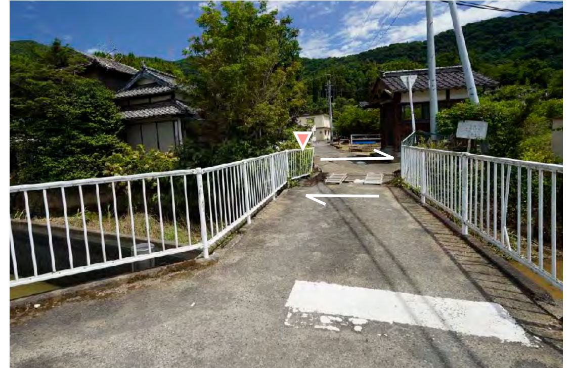
②この地点でも新川の架橋が①同様に横ずれしている
