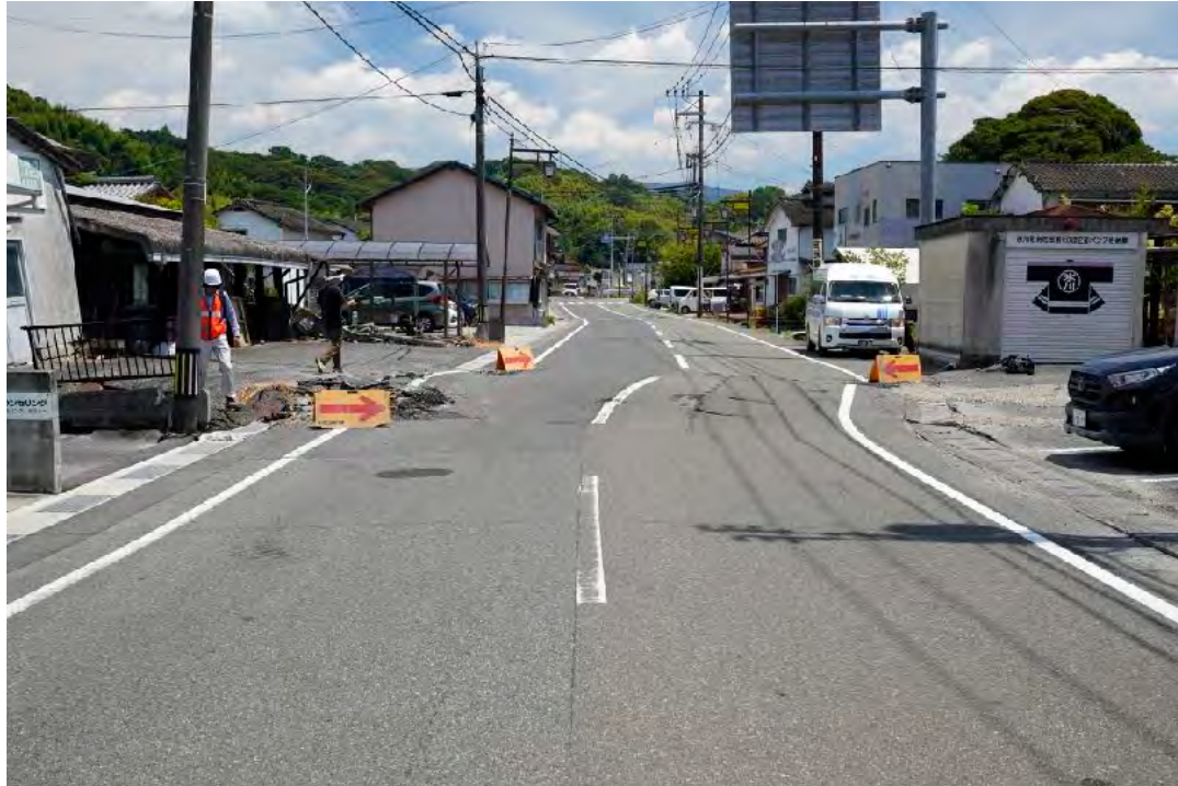
①国道443号線が断層により右横ずれしている
