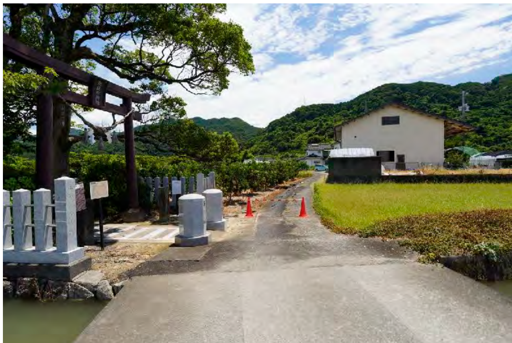
③奈良木神社周辺では、一部にブロック塀の倒壊などが見られるが、外観上大きく損傷した建物は見当たらない。
