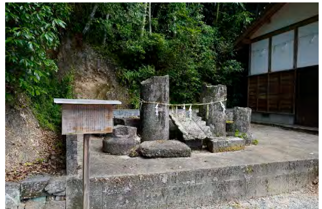
④守山八幡宮境内には、平成28年熊本地震により倒壊した鳥居が保存されている
