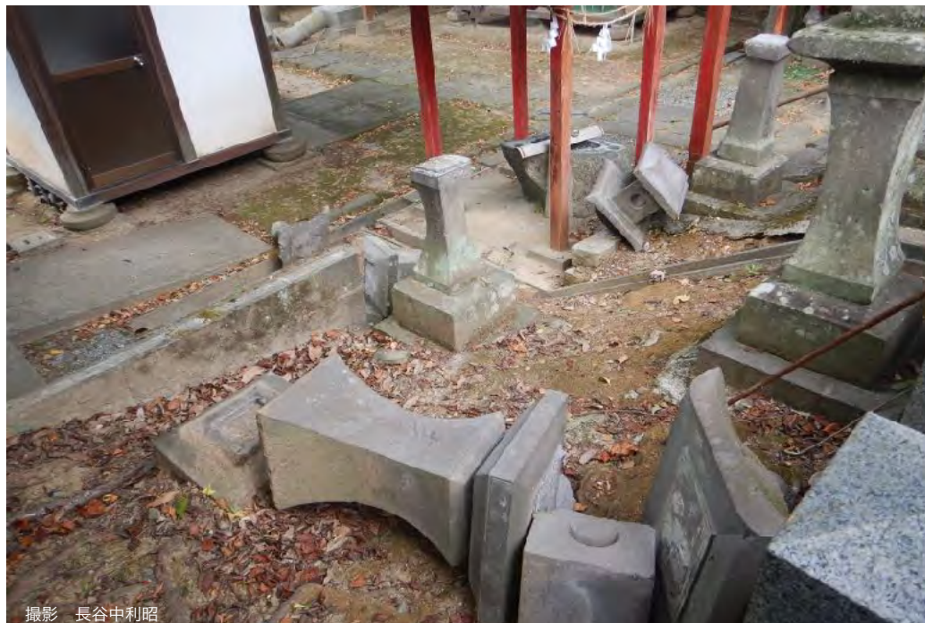
③守山八幡宮前の社殿付近では石灯籠などが倒壊する
