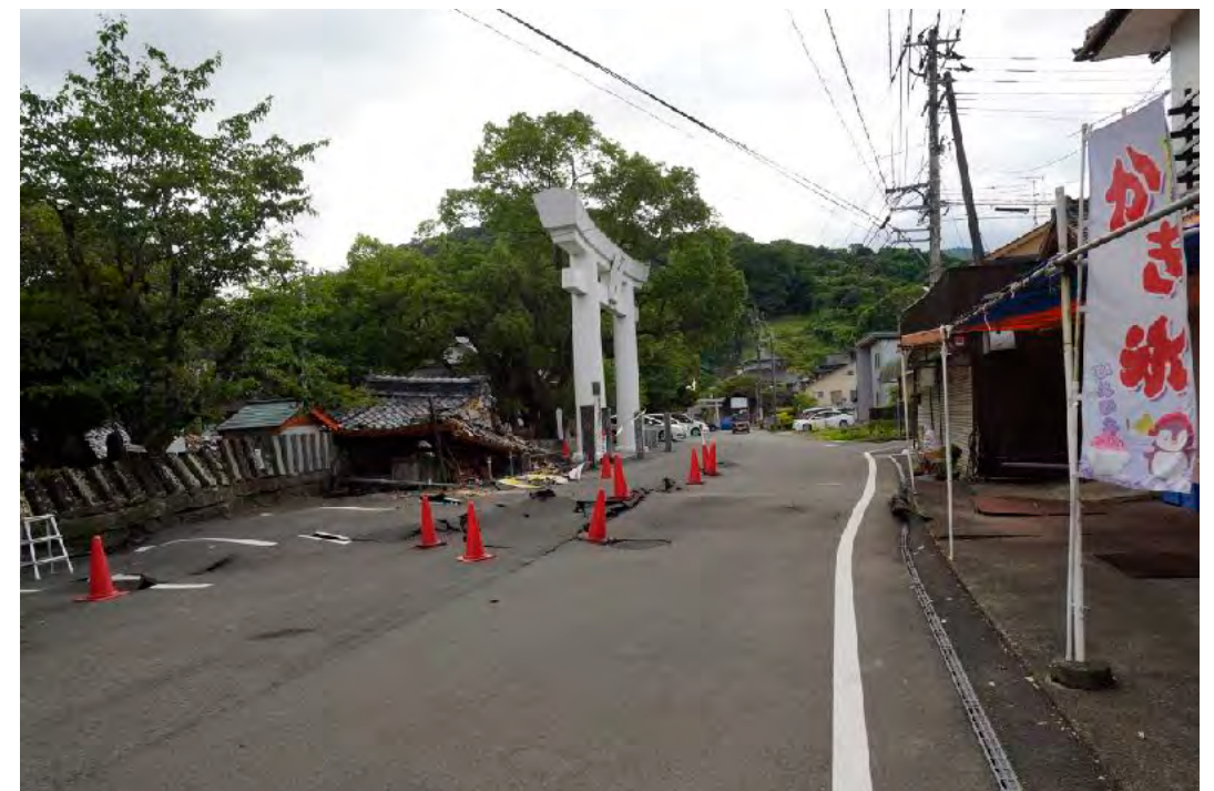
④断層により駐車場と道路が大きく変形し、隣接する社殿が倒壊している。道路の白線は右横ずれを示している
