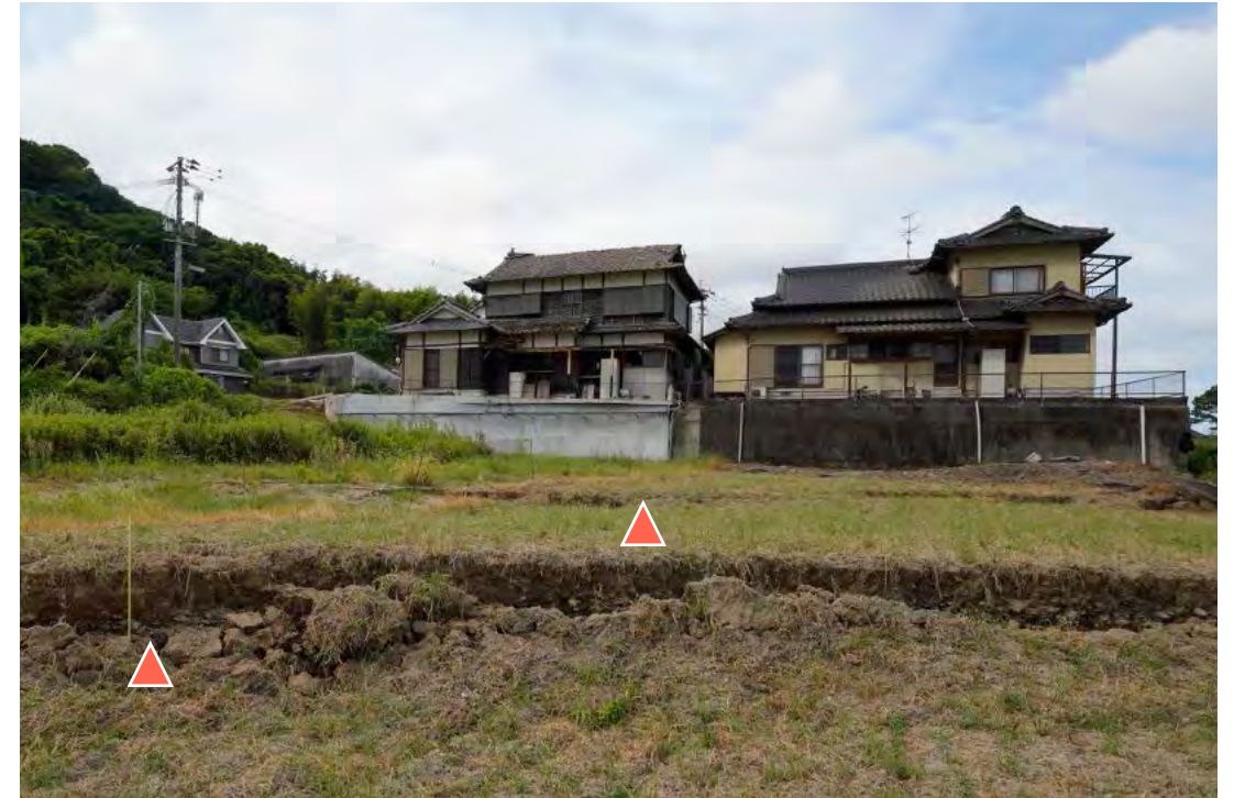
②①撮影地点近くでの別方向のショット。△は雁行するそれぞれの断層。近傍の建物には屋根瓦の崩落があるものの遠望では外観上の大きな損傷は確認できない。
