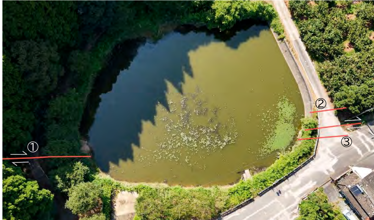
水口下ため池を地震断層が通過する。赤線が断層。道路上の白いスジは地震により生じた亀裂を砂利で埋めている
