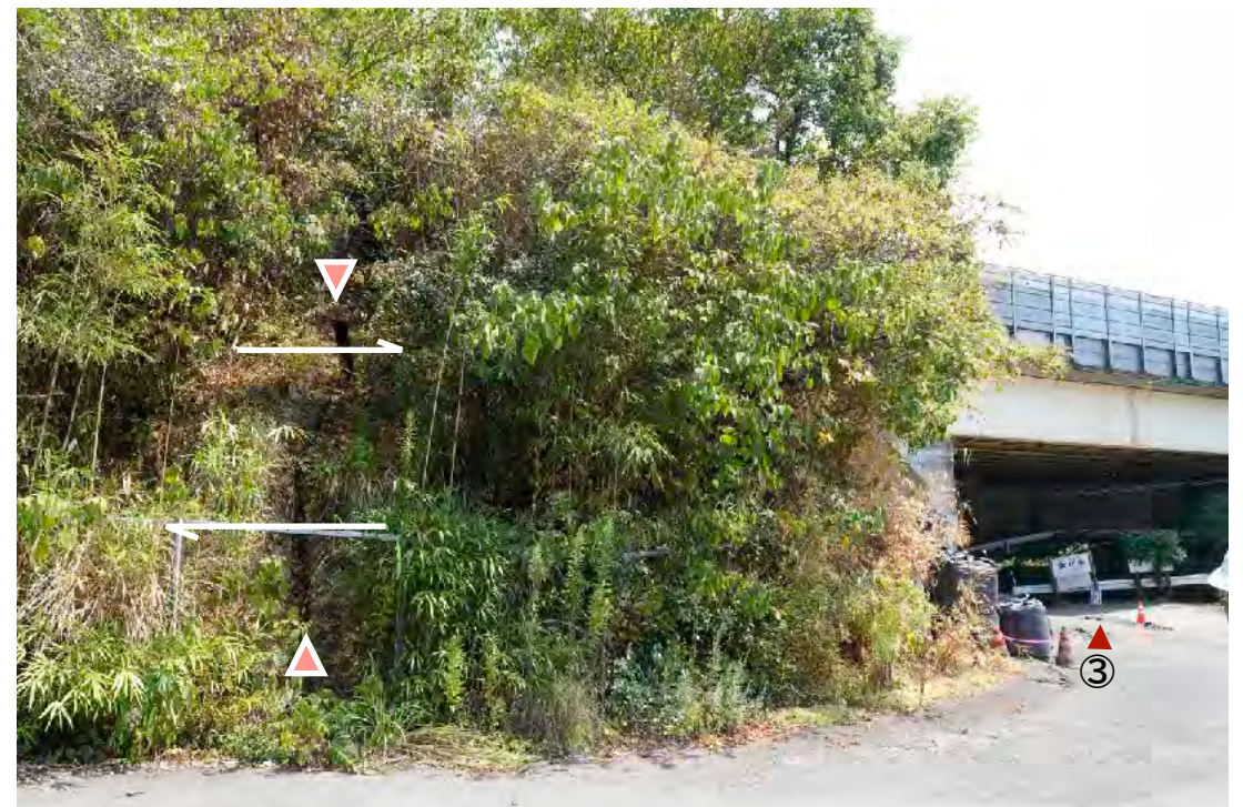
④御手洗水源付近で九州自動車道に平行する右横ずれ断層、道路からの排水路が右横ずれに伴い変形する
